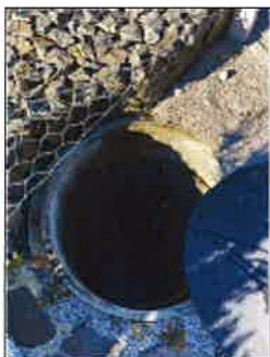
Plastová skruža umiestnená na pri miestnom potoku, pre zachyt úžitkovej vody
