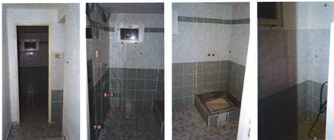
Sociálne zázemie stavby - sprcha, WC, kúpeľňa
