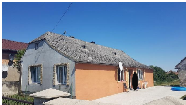
Vstup do RD a spevnená plocha
